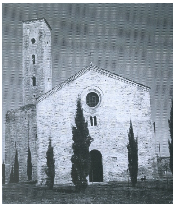
Figura 6 – La basilica trecentesca, dopo i restauri del 1938.
