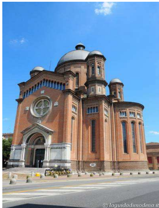
Fig.2 - Il Tempio monumentale di Modena.
